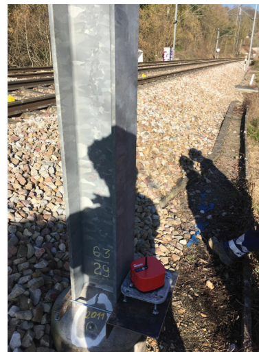
Figure 2. ROCK installé sur un poteau caténaire
