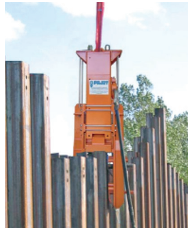
Figure 1. Marteau Pajot 2800 utilisé pour le battage
